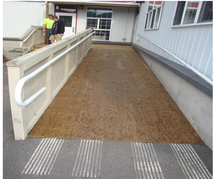
Entrée d'aéroport avant Supa Safe
